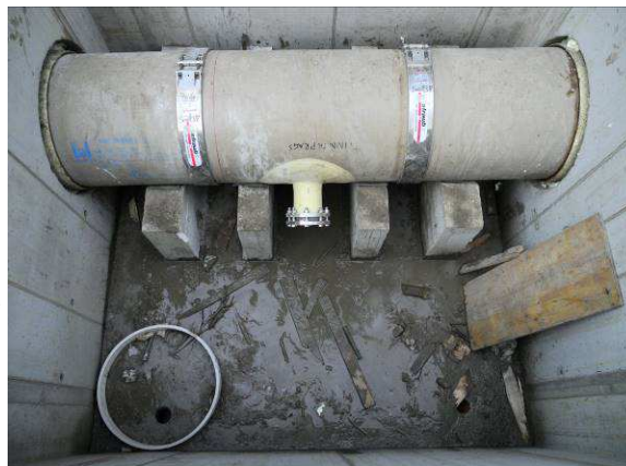
Regelquerschnitt (links) und Schachtbauwerk mit Abgang zur Entleerung der Leitung (rechts)
