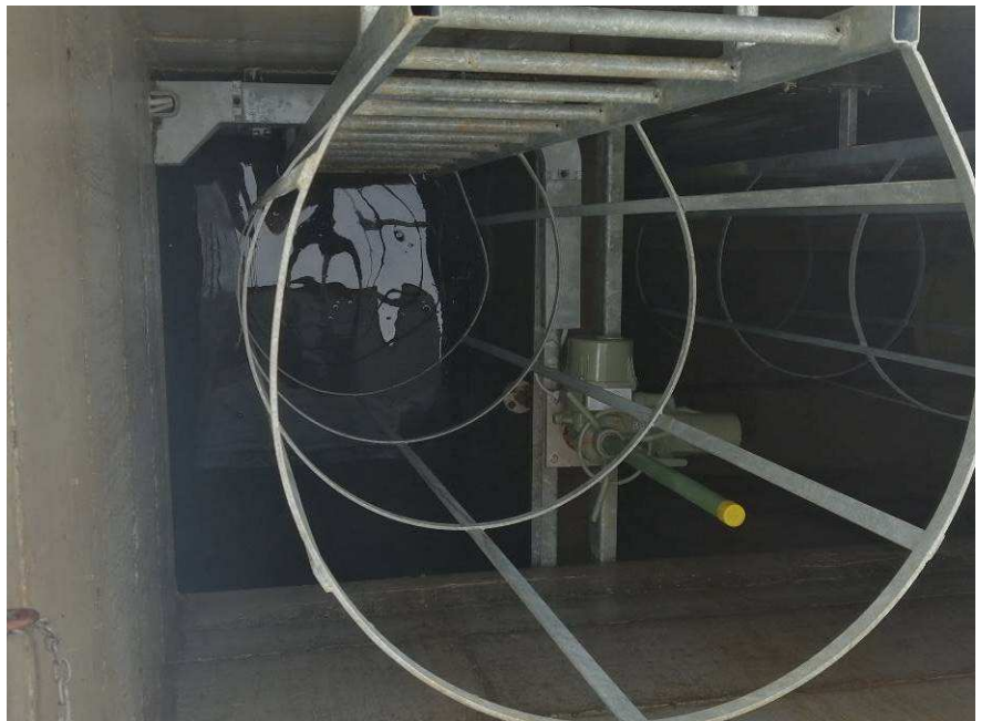
Spülschütz (über Einstiegsöffnungen erreichbar)
